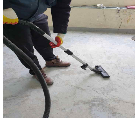
콘크리트 표면 청소
