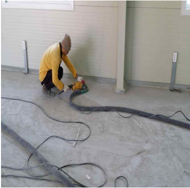
콘크리트 표면 그라인더연삭
